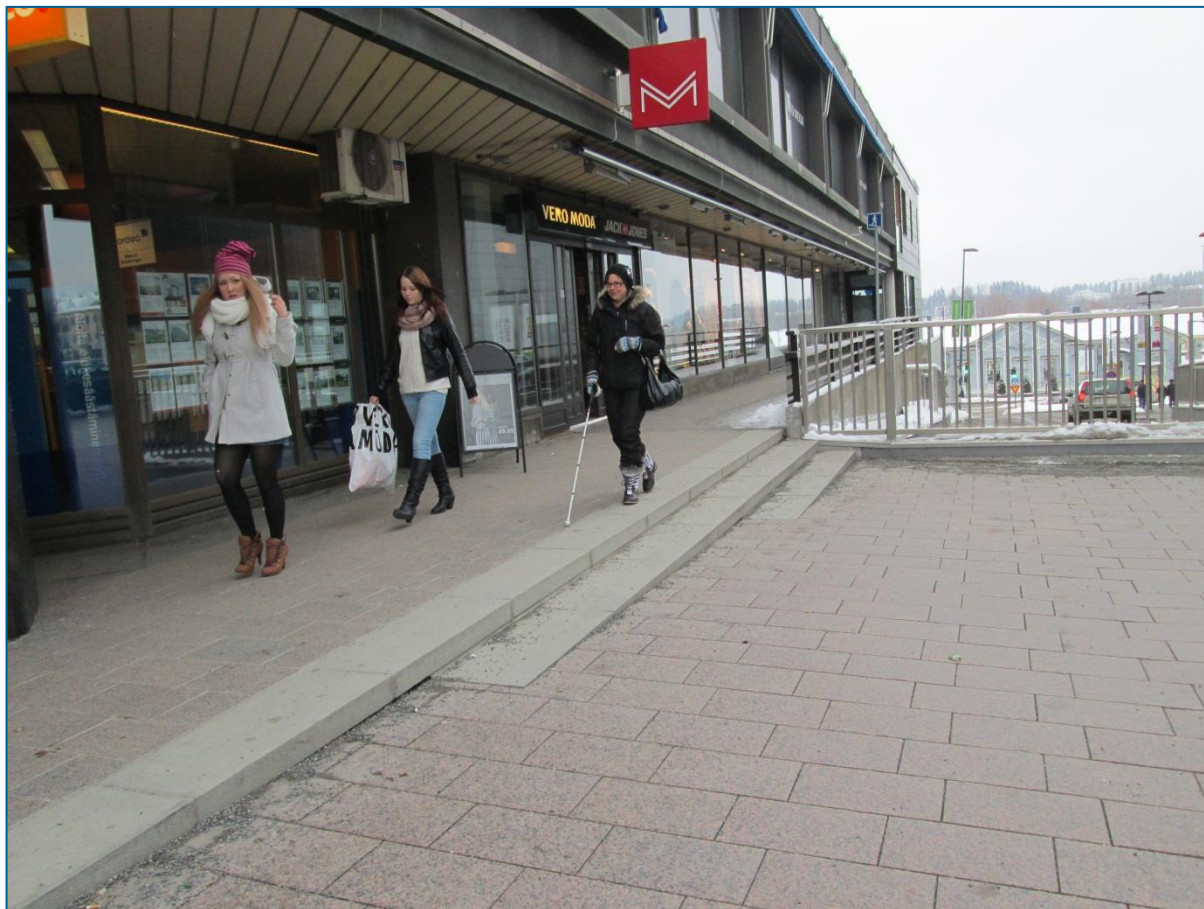
Kuva 6. Hallituskadulle on jätetty kadun saneerauksen yhteydessä kiinteistön portaat paikolilleen ja katu sovitettu portaisiin. Tässä olisi tarvittu kaikilta osapuolilta esteettömyysnäkökulmaa ja neuvottelua esteettömän järjestelyn toteuttamiseksi. Portaat olisi voitu poistaa kadun tasausta muuttamalla. Näin poikkeukselliset portaat yllättävät näkövammaisen.
