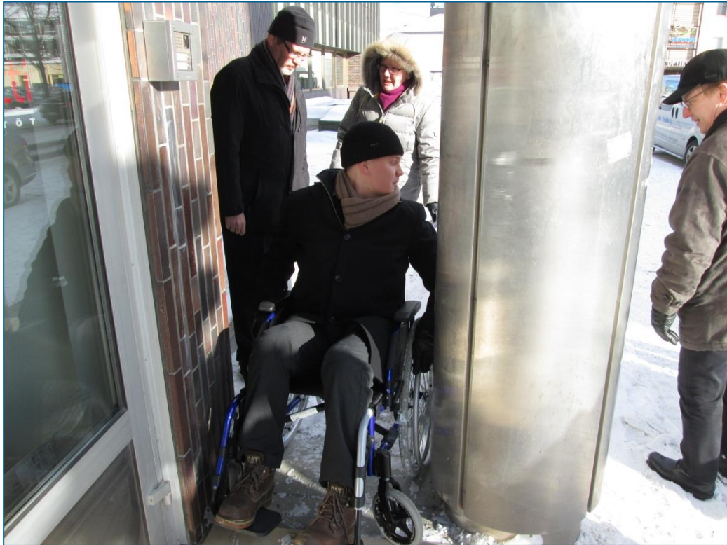
Kuva 4. Valtionvirastotalon sisäänkäynnin viereen tehty luiska, joka on ahdas rako pilarin ja seinän välissä. Tämä kohta on vaikeakäyttöinen avustajankin kanssa liikkuvalla liikuntarajoitteiselle.
